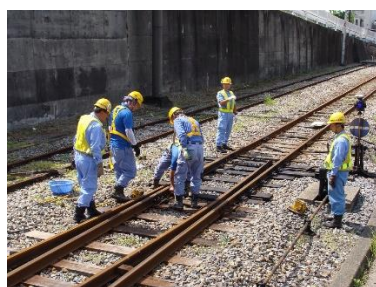
(参考・線路の点検の様子)
