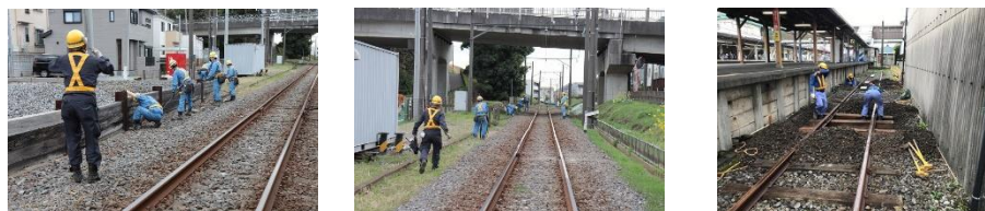
(参考・保守作業、点検の様子)
